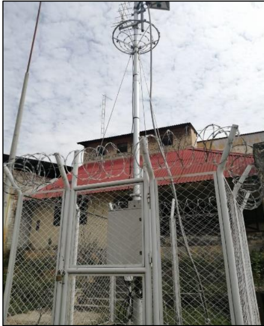
E. Puente Internacional Macará
